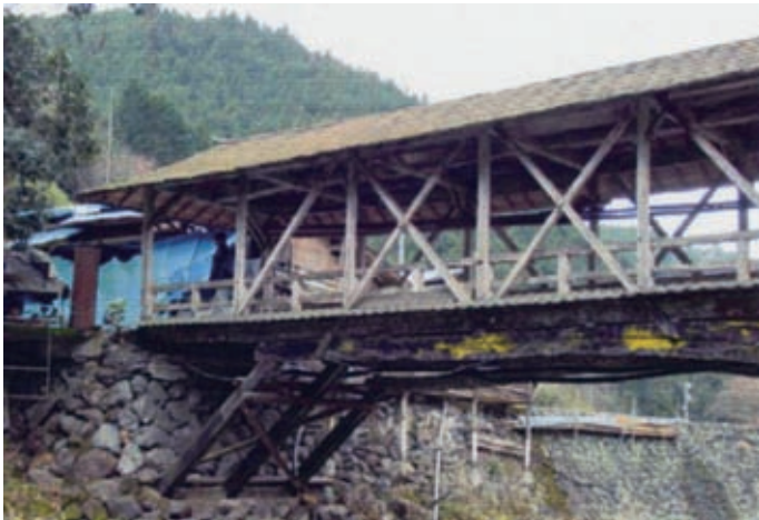
図 4.4 国内で最も長寿の木造橋 三嶋橋
