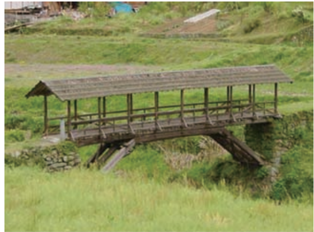
図 4.5 土木学会から選奨土木遺産に 選奨された田丸橋
