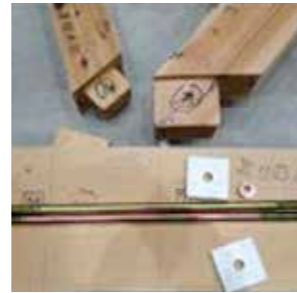
図1.下弦材(陸梁)と斜材、側束の仕口
