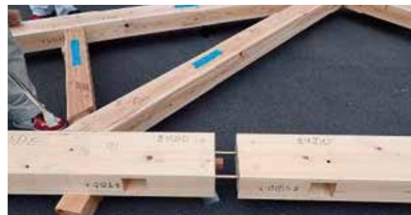
図3.下弦材(陸梁)の継手
