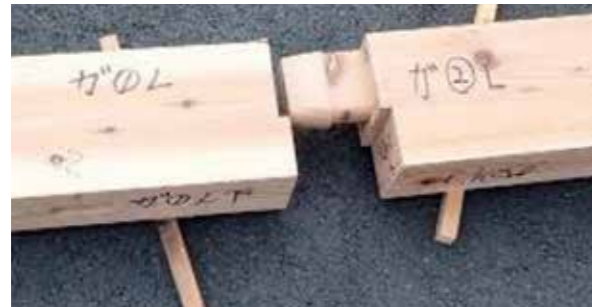
図2.上弦材(登り梁)の継手
