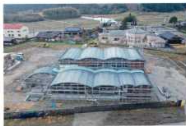
建物外観 (ドローン写真)
