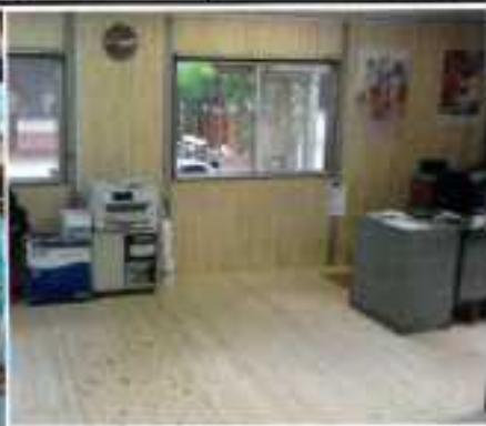
内装材(壁・床)に県産材を使用
