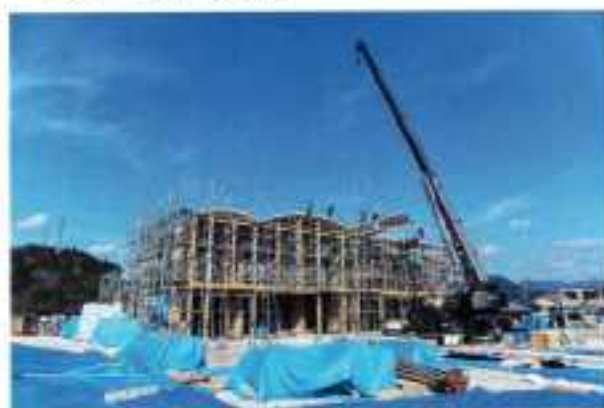
CLT屋根施工中写真
