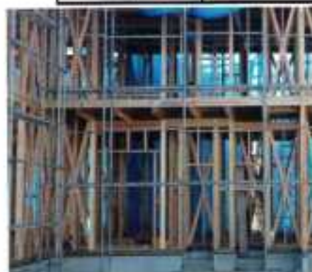
構造材に県産材を使用
