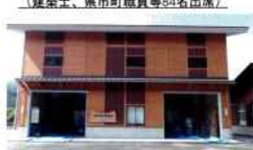
新しい試験機器を整備し新築された 愛媛県林業研究センター木材第3実験棟
