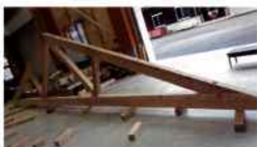
完成した媛トラス
